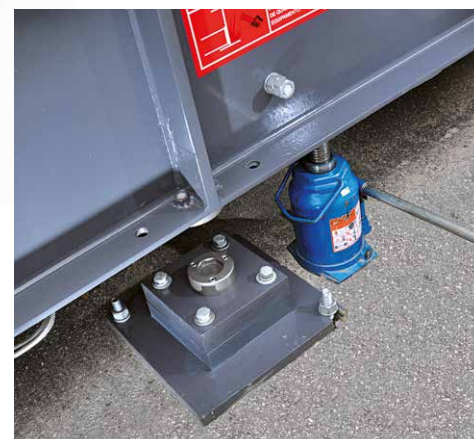
Retirada do pino de apoio, com auxílio de macaco hidráulico, e preparação para instalação da célula de carga inteligente.
